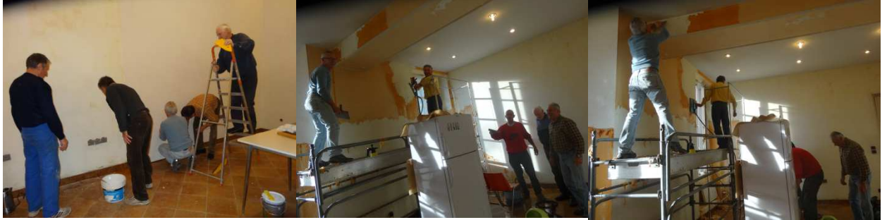
Préparation des murs et peinture
